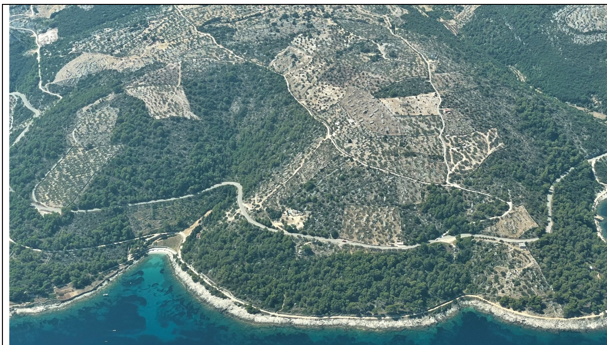
Slika 7: Pogled na ŽC6161
